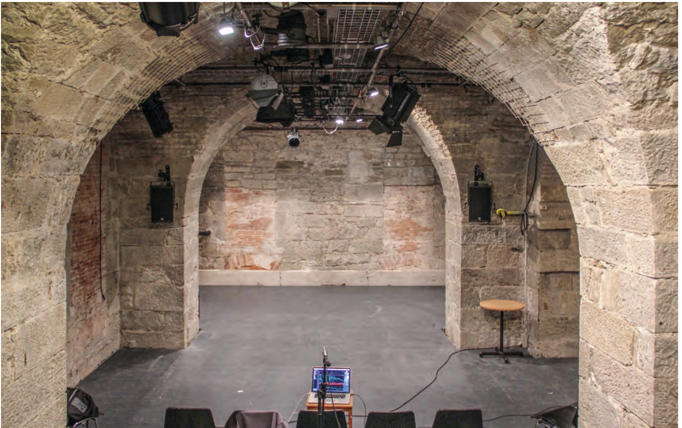
Die Kellerwölbungen im Theater Winkelwiese sind besonders hinsichtlich Klang eine Herausforderung.
