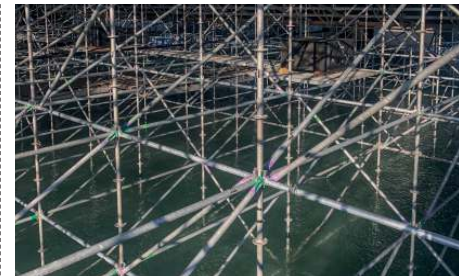
Die Lasten von ca. 900 Tonnen wurden über Stützpfeiler und massive Holzplatten in den Seegrund abgetragen.
