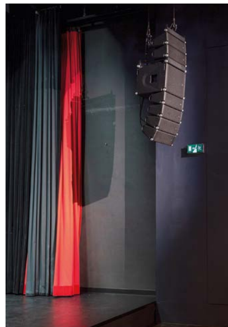
Kleintheater Luzern: Bühnenportal mit CODA Audio TiRAY und TiLOW Bass Extension.
