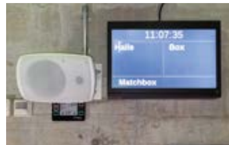
Die IP-Lautsprechermodule – hier mit externem Control Panel – wurden speziell entwickelt.
