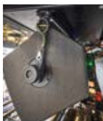
Die 230 Lautsprechermodule sind mit einer Fernwartoption ausgestattet.
