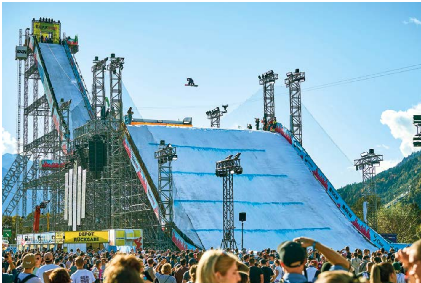
Riesenkicker für die Freestyler: Die mit 300 Tonnen Stahl aufgebaute Big-Air-Rampe war 40 Meter hoch und 140 Meter lang.
