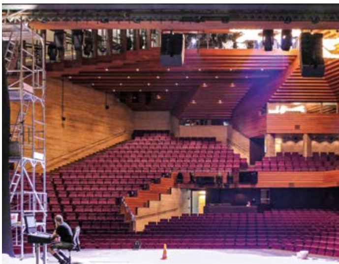
Im sanierten Theater St. Gallen gab es viel neue Technik einzurichten.
