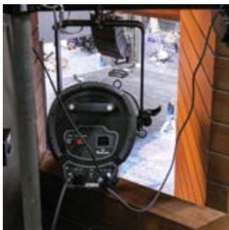
Für die LED-Scheinwerfer mussten teils spezielle Halterungen installiert werden.
