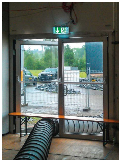
Im Notfall zählt jede Sekunde: Fluchtwege müssen stets freigehalten werden.
