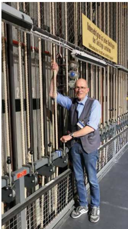
Das altherwürdige Theater am Herrenacker ist noch mit Handkonterzügen ausgestattet.
